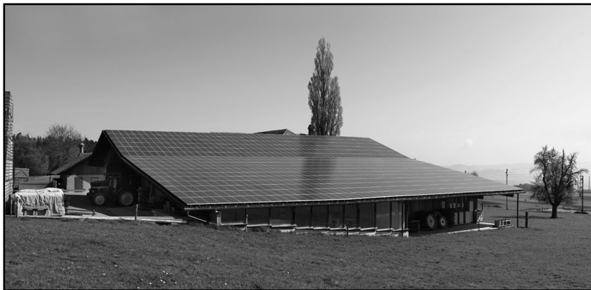
Installation de panneaux solaires sur un bâtiment agricole. Photo Solstis SA
