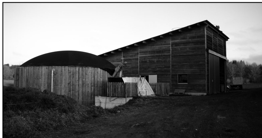
Biodigesteur pour la production de biogaz à partir de lisier de ferme. Photo S. Boéchat
